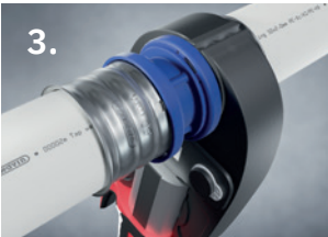
3. Verpressen mittels Akkupresszange, Akku-presszange „Mini“ oder Elektropresszange.
