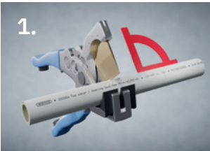
1. Rohr rechtwinklig ablängen.
